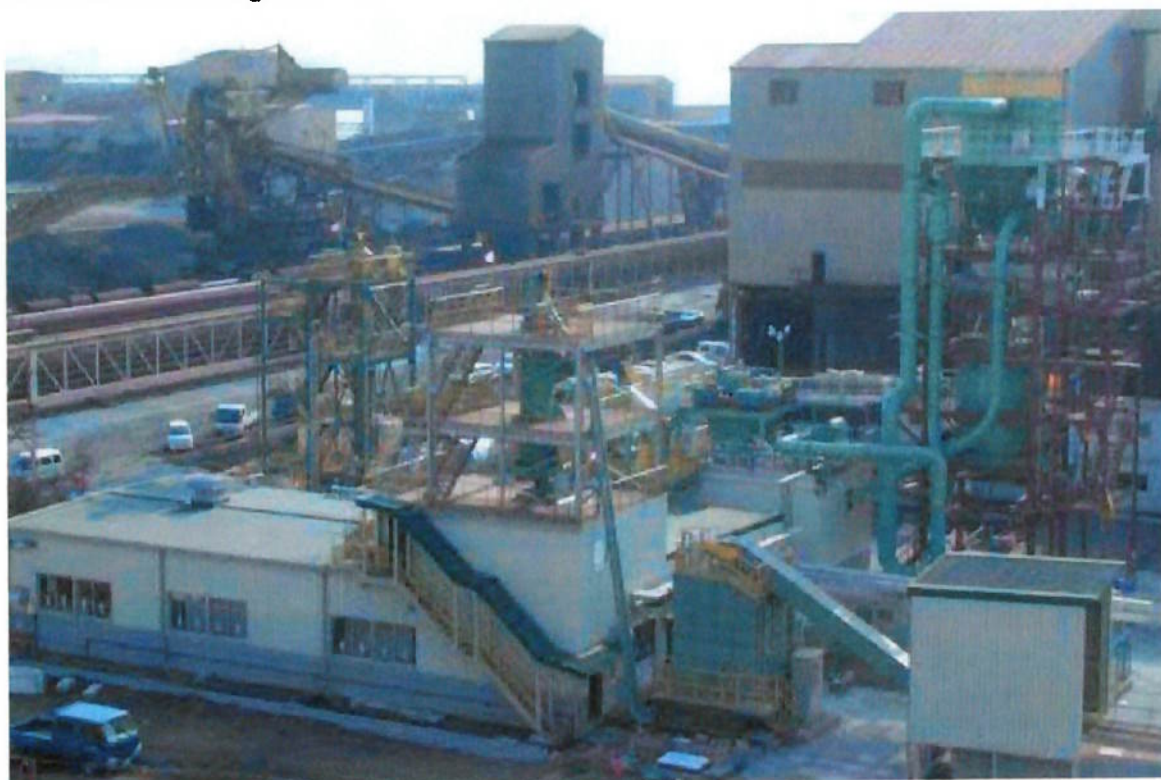
Figura 64 - Vista geral da usina APR da NKK
